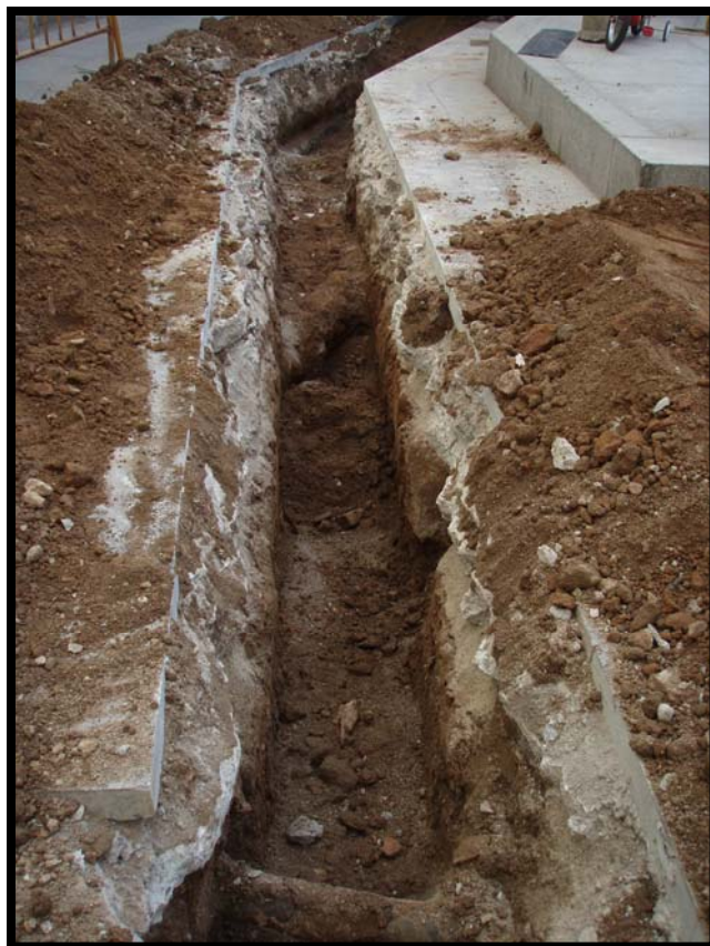
Tram de la rasa 200
