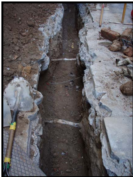
Tram de la rasa 100
