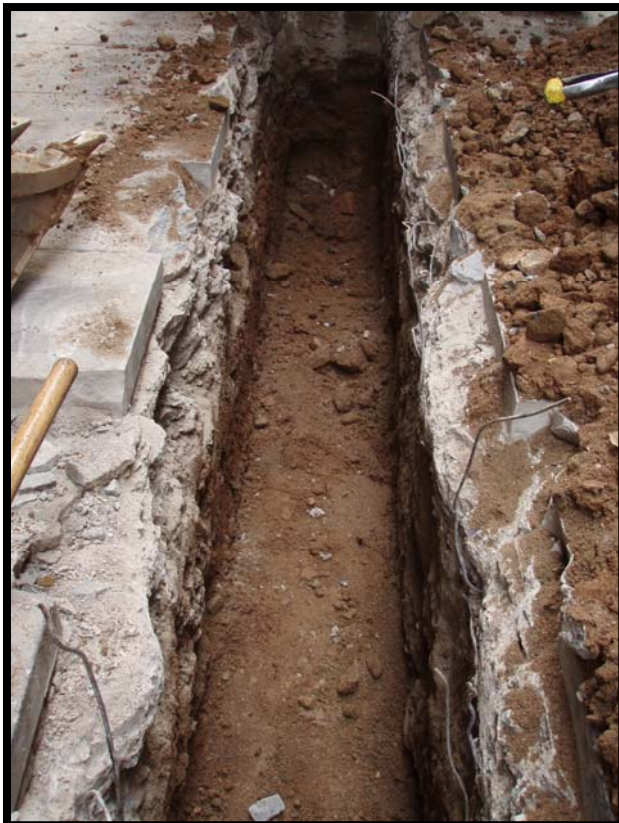
Tram de la rasa 100
