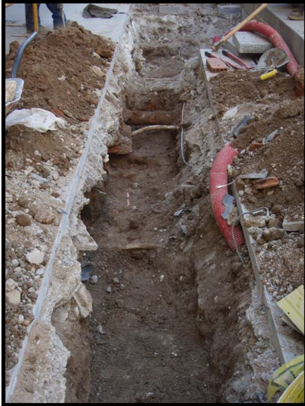
Tram de la rasa 200
