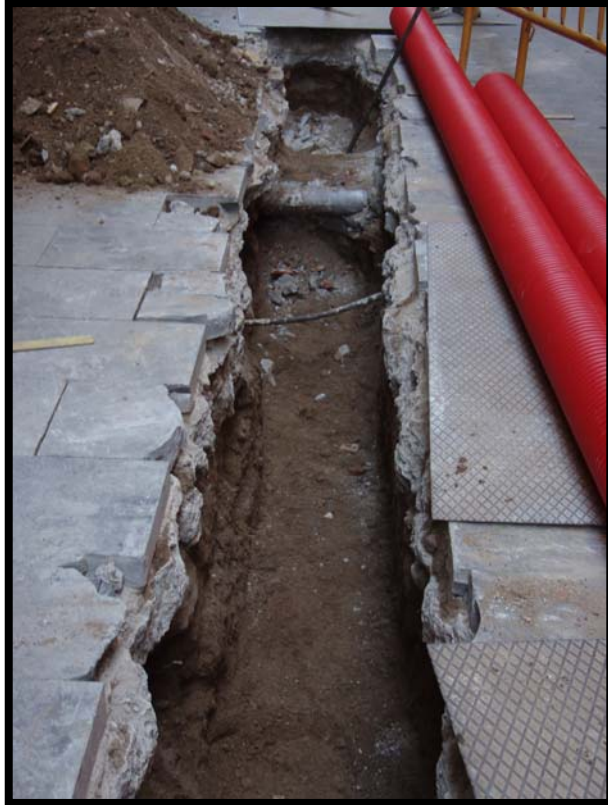
Tram de la rasa 100
