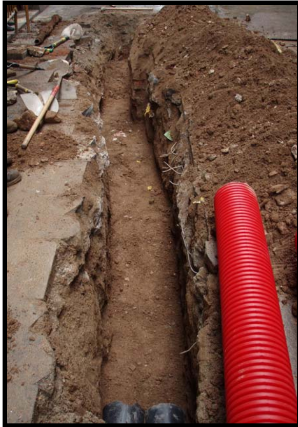
Tram de la rasa 100
